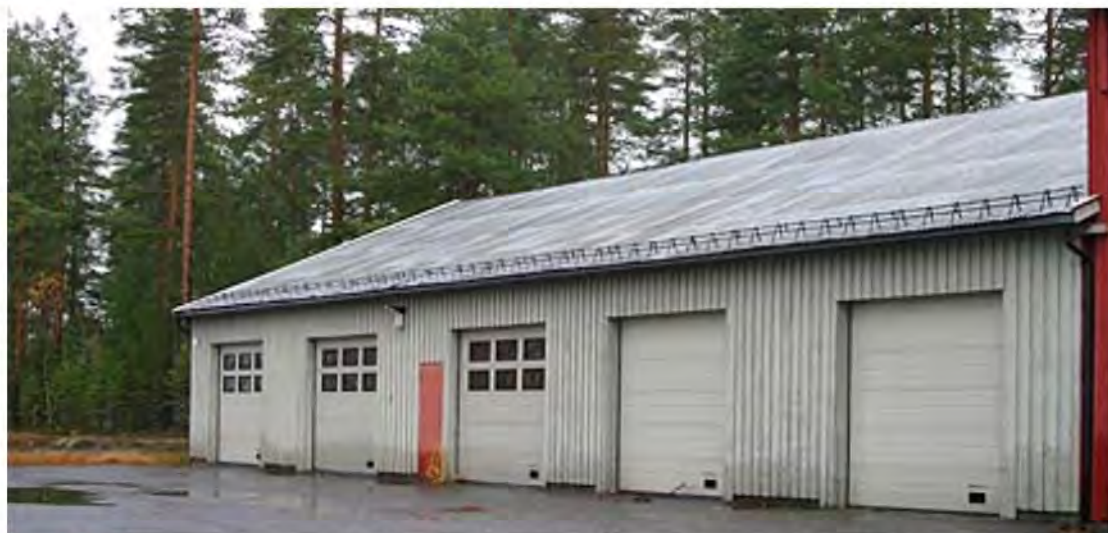
NEDLAGT: Kongsgårdmoen militærleir ble lagt ned i 2004, mens Kongsgårdmoen fjellanlegg skal ha vært i drift frem til 2010. Foto: FORSVARSBYGG
