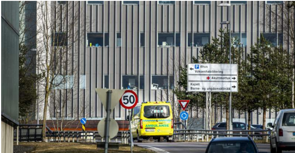
VARSLER: Vernetjenesten ved Akershus universitetssykehus (Ahus) varslet i september om kvaliteten på utstyret fra det nasjonale beredskapslageret. Nå er det opprettet tilsynssak hos Arbeidstilsynet.
